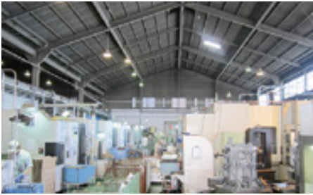
加工工場 全景
