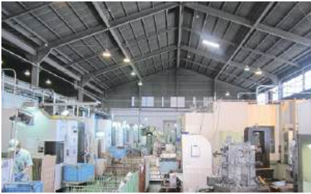
加工工場 全景
